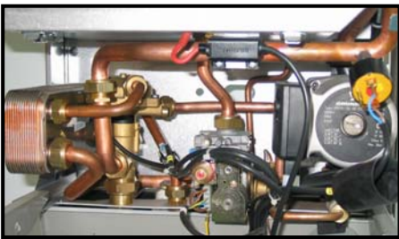
MiniTech/Plus 25 vecchia versione V.01 "Blocco idraulico "
